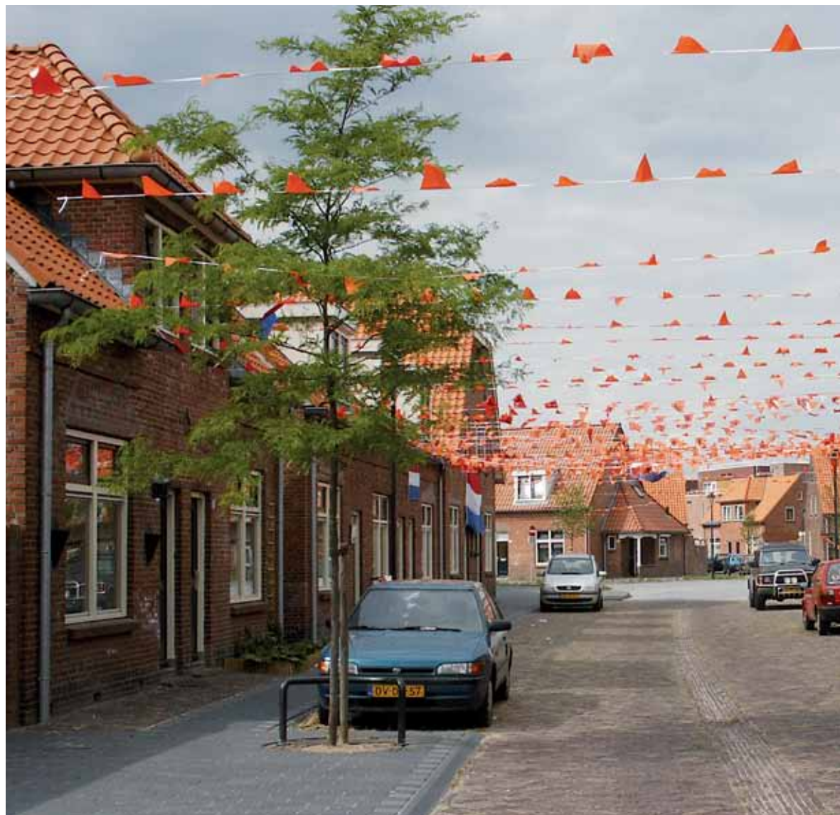
EEN STRAATPROFIEL, IN DE WIJK PATHMOS, DAT NIET TONROND IS, MAAR DE VORM HEFT VAN EEN OMGEKEERD DAKPROFIEL.
