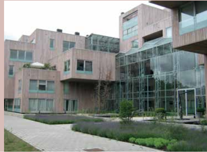
GEVELBEKLEDING, MOEILIK BEREIKBAAR VOOR ONDERHOUD, CRYSTAL COURT AMSTERDAM.
