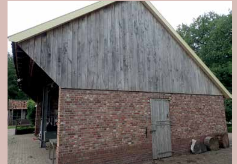
ONAFGEWERKTE EIKEN GEVELBEKLEDING, VERGRIJSD, NEEDE.
