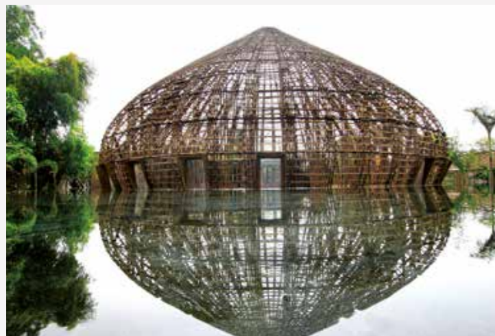
DE WIND AND WATER BAR LAAT DE ENORME POTENTIE ZIEN VAN BAMBOE ALS CONSTRUCTIEF MATERIAAL.
