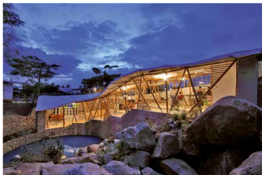
IN DE CONSTRUCTIE VAN HET KANTOOR IN BANGALORE IS BAMBOE GEÏNTEGREERD TOEGEPAST.
