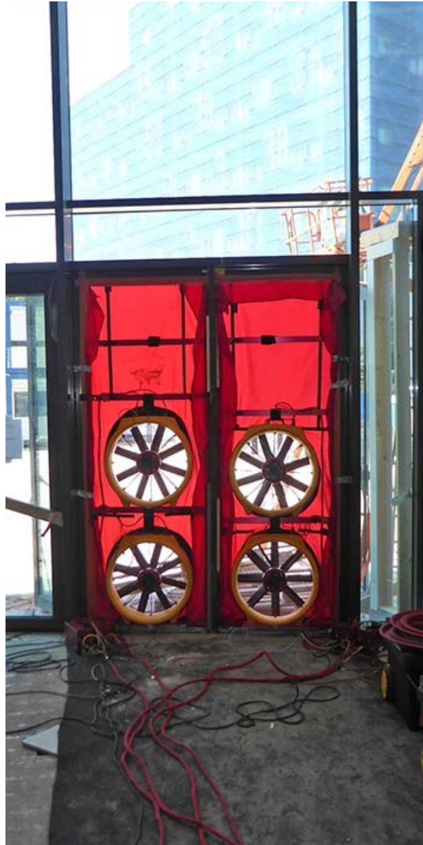
Blowerdoormeting na het wind- en waterdicht maken van het gebouw
