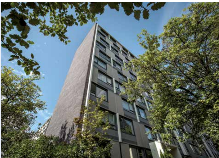
REVITALISATIE ACA-FLATS UTRECHT-OVERVECHT.
