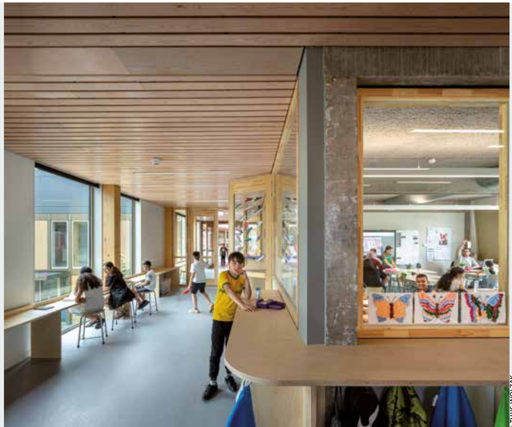
IN DE RUIIME GANGEN MET VEEL DOORKIJK NAAR DE LOKALEN IS DE RUWE BETONNEN FUNDERING DUIDELIJK IN ZICHT GEHOUDEN.
