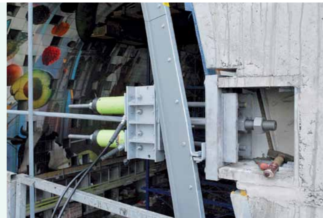
AFBEELDINGEN BOVEN: KNOOP KABELS. FOTO LINKS: TIJDELIJK HULPMIDDEL GEBRUIKT OM DE KABELS OP VOORSpanNING TE BRENGEN.
