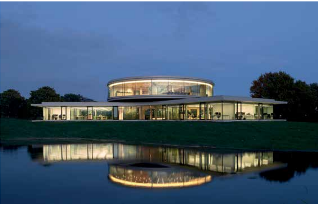
HET KANTOOR VAN DE KRINKELS GROEP STAAT OP ENIGSZINS OPGETILDE GROND, CONFORM ENGELSE LANDGOEDPRINCIPES.
