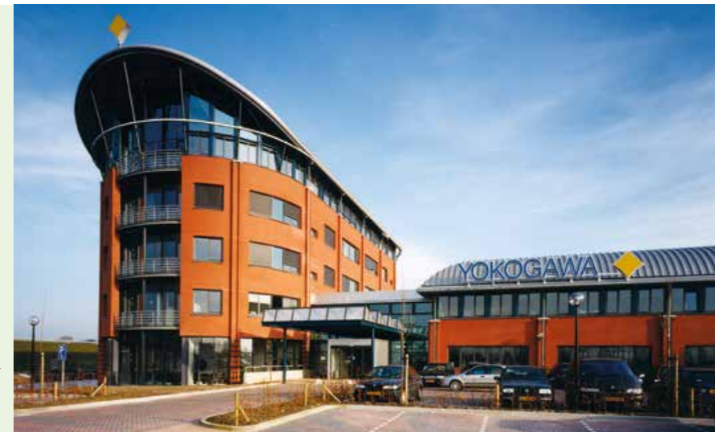
YOKOGAWA KANTOOR MET MAGAZIJN LANGS DE A1 BIJ AMERSFOORT.
